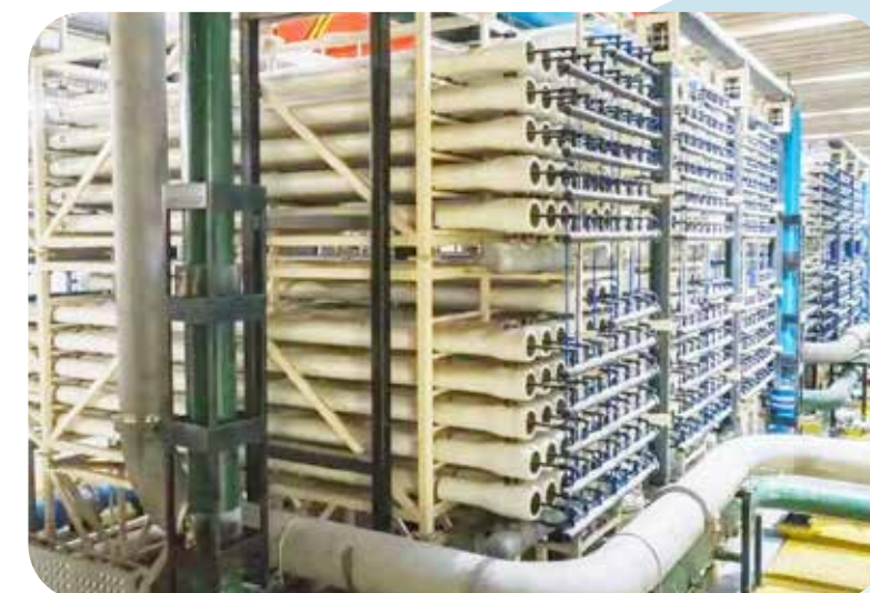
青岛董家口海水淡化工程，10万m 3 /d，UF+RO
