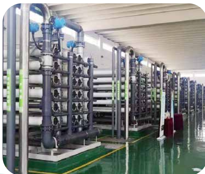
江苏某自来水厂深度处理工程 5万m 3 /d, NF膜
