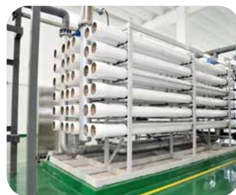
陕西某工业区水质改善工程 20万m 3 /d, NF膜
