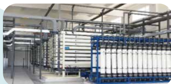
云南某污水处理厂，2.5万m 3 /d，NF膜
